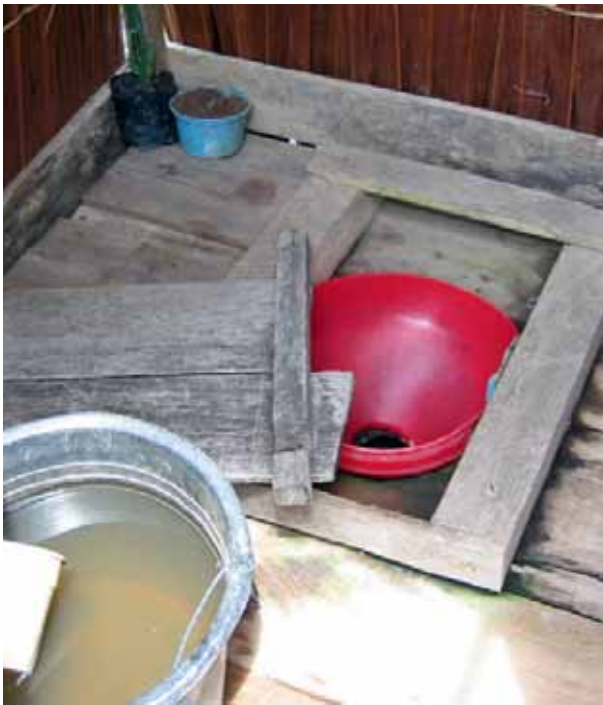
ARRIBA una letrina utilizada en Sud Sumatra, Indonesia. Una mujer utilizó varios materiales de la casa para cumplir con la decisión de la comunidad de ser LDCA, mientras su esposo estaba de viaje.
