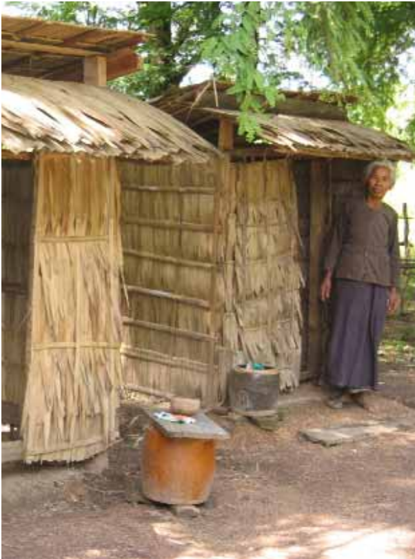
ARRIBA Note el recipiente de agua y jabón delante de algunas letrinas recién construidas en las aldeas de la provincia de Kampung Spu en Camboya
