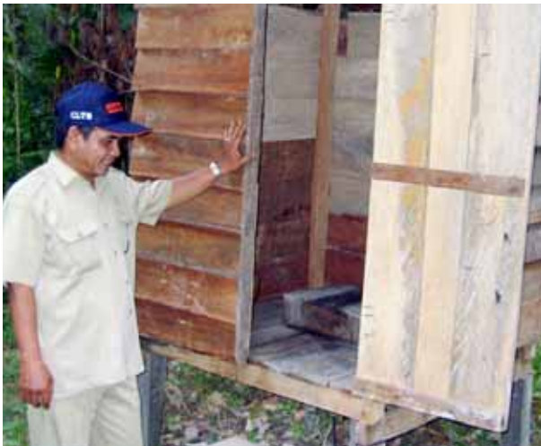
ARRIBA Plataforma elevada de un inodoro para evitar las inundaciones estacionales en Indonesia.
