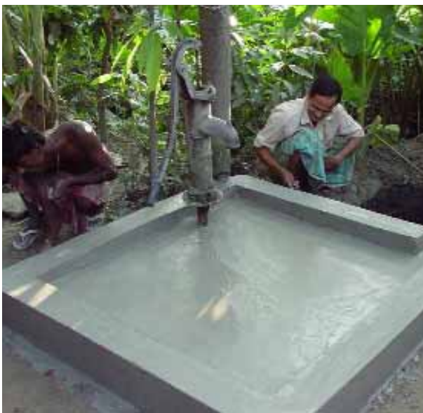
ARRIBA Y DERECHA - Mujeres de la comunidad de Vidyasagar de la colonia de Kalyani, en la Municipalidad de West Bengal, India, decidieron pavimentar las bases de todas las 69 bombas manuales de su colonia y construyeron plataformas de cemento para evitar la acumulación de aguas sucias, basura y mugre alrededor de sus fuentes de agua segura. La Municipalidad les proporcionó una cantidad de ladrillo no utilizado y el resto lo hicieron ellas por sí solas. Todo sucedió al cabo de dos meses de haber recibido su calificación LDCA. Este fue el primer tugurio en lograr la calificación LDCA. Después de un año, los 52 tugurios dentro de la municipalidad fueron declarados LDCA.
