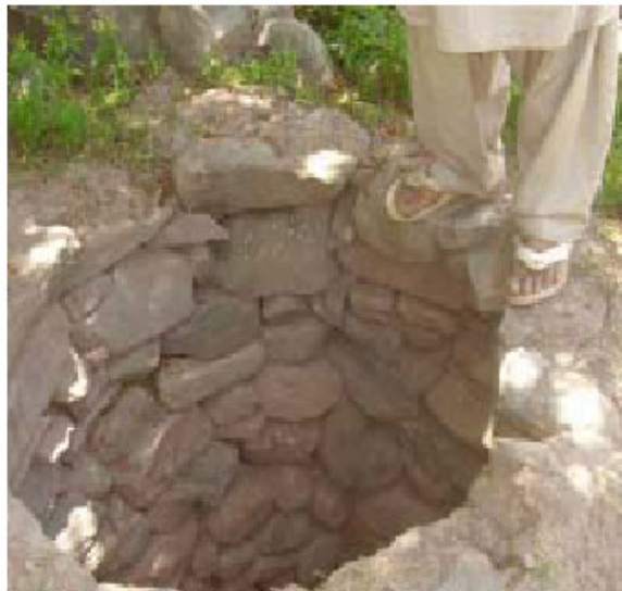
Atas: Batu-batu yang digunakan dalam LINING THE SOAK PIT: SYed Shah Nasir Khisro, IRSP, Mardan, NWFP, Pakistan.
