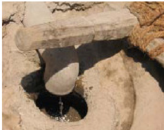
ATAS DAN KIRI: penduduk setempat menciptakan cara yang unik untuk menyerap air limbah cuci dari ruang cuci ke dalam pot yang dilubangi dan dikubur di dalam tanah dan ditutupi dengan batu kerikil dan batu-batu lainnya di sebuah desa Maharashtra di India. Hal ini membuat jalan tetap kering dan bersih yang sebelumnya berlumpur dan kotor.
