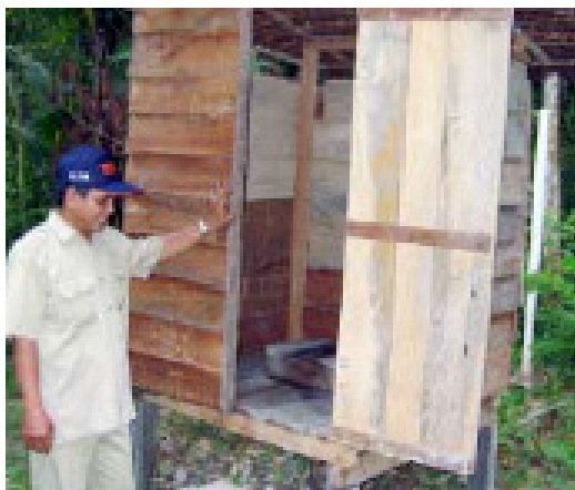
ATAS: Platform yang dinaikkan di toilet untuk menghindari banjir musiman di Indonesia.
